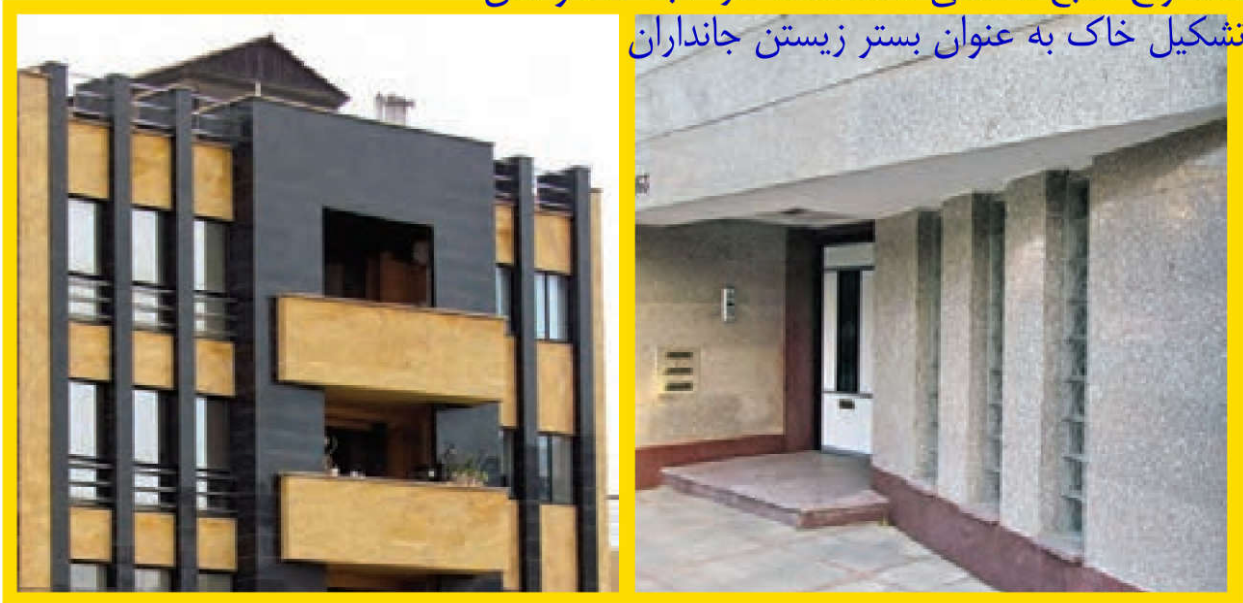
ب) نمای سنگی ساختمان
